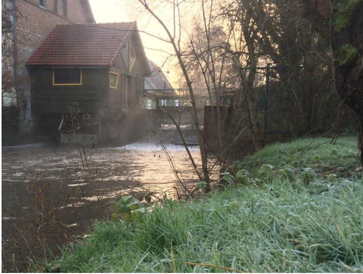
Figure 2: Vue aval du piège de Beauchamps
