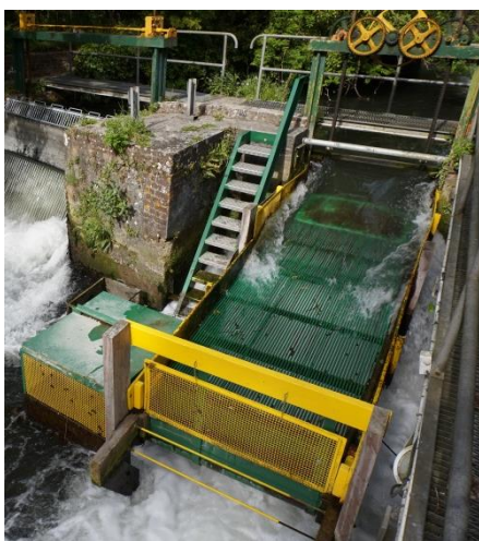
Figure 13: Vue du dispositif de piégeage de dévalaison d'Eu
