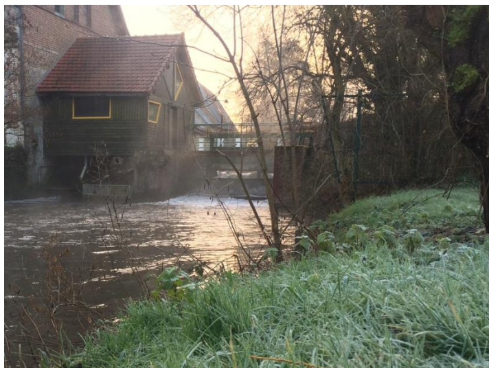
Figure 2: Vue aval du piège de Beauchamps
