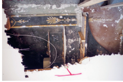
Niche décorée du XIX e siècle (Ailes nord et est, RDC)
