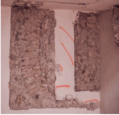
Bâtiment Ouest – R+1 – Porte à mi-hauteur (UM 5)
