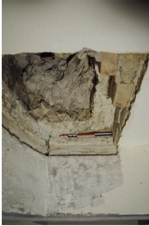
Bâtiment Ouest – RDC – Parloir condamné, détail de l'ancrage du système de fermeture initial
