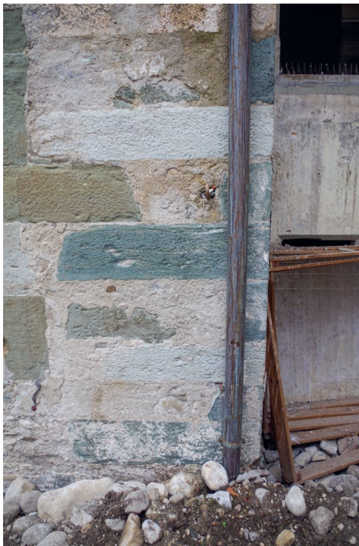
III. 07 : Diversité des matériaux employés dans le bâti de l'aile ouest (chœur des religieuses) : chaînage extérieur de l'angle sud-est comprenant des pierres de taille en grès et calcaire, voisinant des pierres en molasse. Le reste du parement, ici non décroûté, se compose de galets ; photographie : Quentin Rochet
