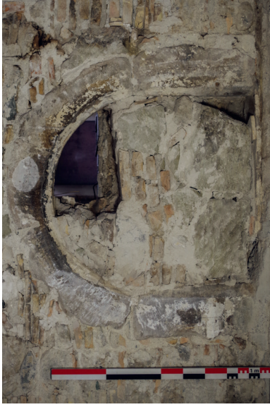
Vue de détail de l'arche en pierre en pierre du bâtiment ouest (R+1).
