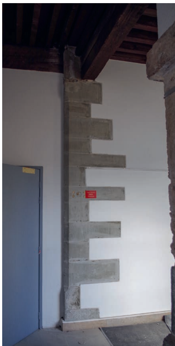
III. 04 : Exemple d'usage de la molasse dans la construction de l'aile ouest (chœur des religieuses) : chaînage extérieur de l'angle sud-est (UM 30/UM 40) vu depuis la galerie sud du cloître; photographie : Quentin Rochet
