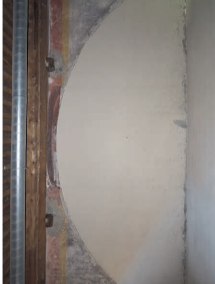
Mur nord de l'ancienne infirmerie, l'arc de la base dominant sur le chœur est visible au centre du mur.
