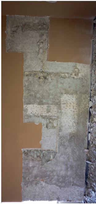
Sondage dans le mur sud du bâtiment sud-ouest (R+1), à l'ouest de la baie actuelle. Sont visibles deux baies rebouchées, ainsi que les refends consécutifs à l'arrachage de deux murs de refends ou cloison.
