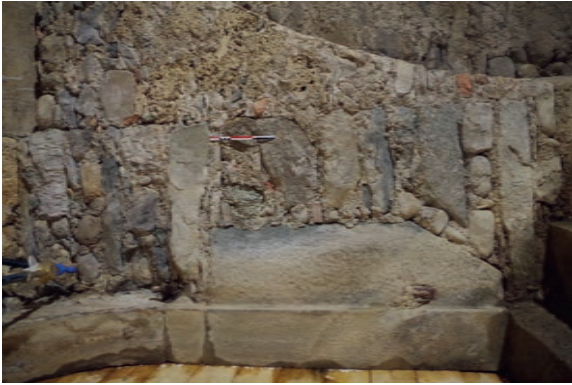
Bâtiment Ouest – R-1 – Appareil du mur UM 7 et de la voûte UM 9
