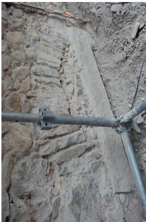
Vue du linteau chanfreiné au pied du mur gouttereau nord.
