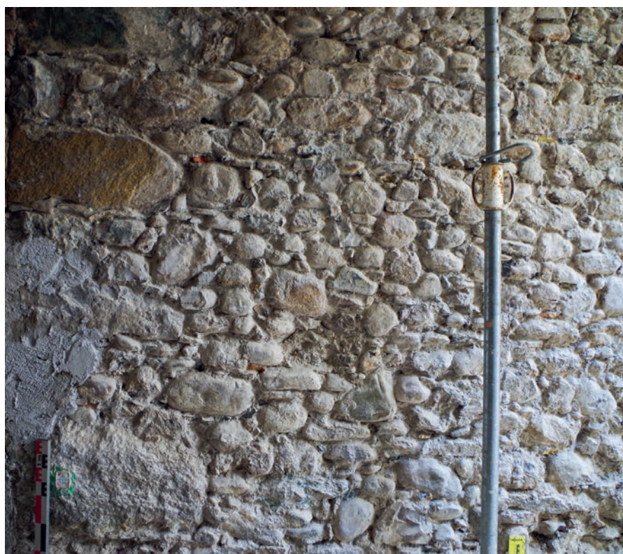
III. 03 : Parement de galets dans le mur occidental du bâtiment sud-ouest (UM 23); photographie : Quentin Rochet
