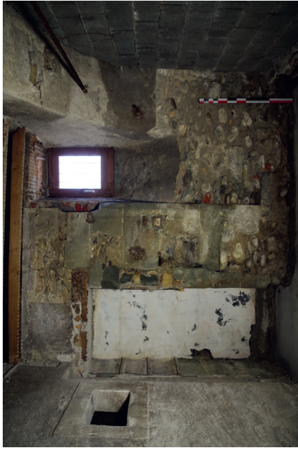
RDC du bâtiment sud-ouest, immédiatement au sud de la cage d'escalier (espace du lavoir). Est notamment visible au centre le chaînage d'angle sud-ouest de l'aile sud, lequel forme le piédroit d'une porte, dont on peut encore voir un élément de seuil en partie inférieure, et l'ancrage du linteau en partie supérieure.
