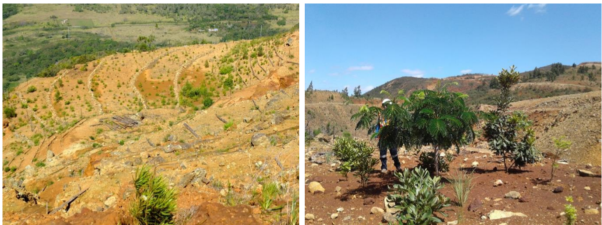
Figure 3 : (a) Restauration d'une mine orpheline (petits ouvrages de stabilisation et de gestion des eaux et plantations d'espèces natives) réalisée sans moyens mécanisés (chantier TAO3 du Fonds Nickel) ©Fonds Nickel et (b) Plantations sur la mine de Kouaoua avec régalage de topsoil et intégration d'espèces fixatrices d'azote, ici Serianthes calicina , en mélange avec d'autres espèces pionnières natives, dont certaines sont connues comme étant des hyperaccumulatrices d'éléments traces métalliques ©F. Bailly, CNRT.
