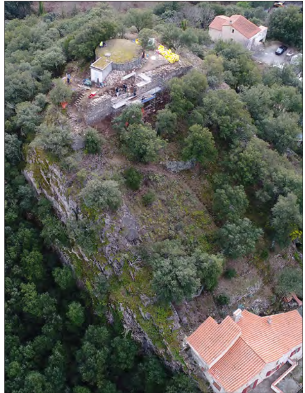
III. 52 : Vue depuis le nord du parement arraché de la muraille.
