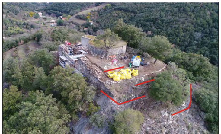
III. 48 : Vue des différents murs se développant du côté sud.
