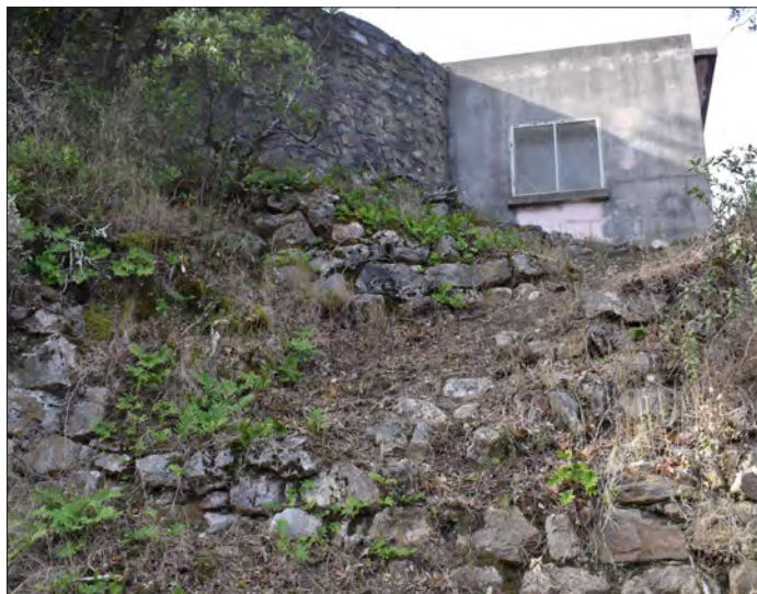
III. 49 : Vue de la trouée depuis l'est.
