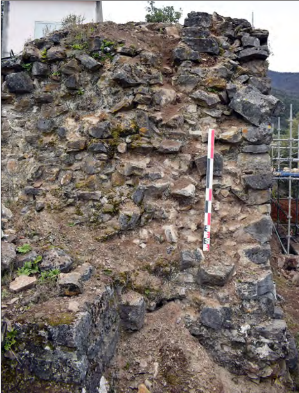
III. 51 : Vue depuis le nord-ouest du château.
