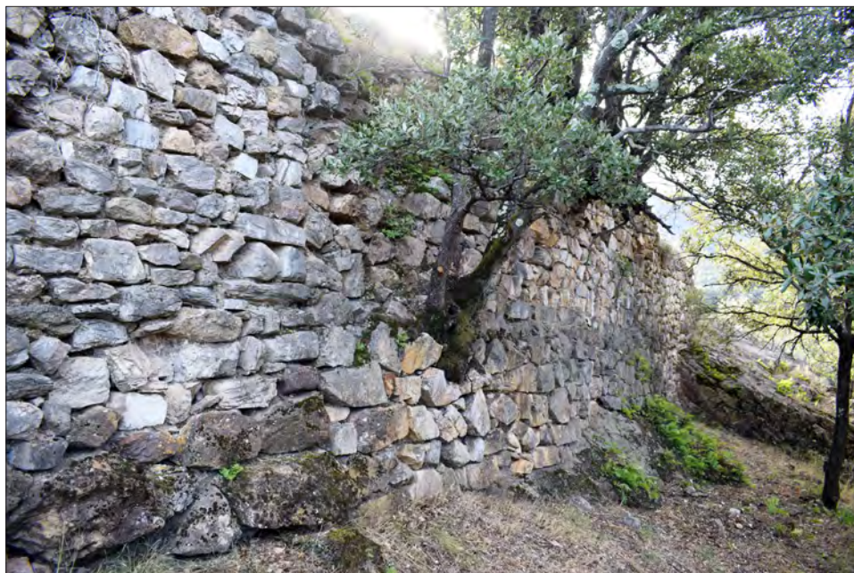
III. 54 : Vue depuis le nord-ouest de MR 2004 au premier plan et MR 3001.
