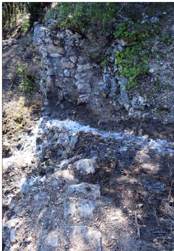
III. 50 : Vue de l'écoulement de la vidange sur la muraille est.
