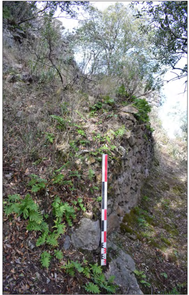
III. 37 : Vue depuis le sud du mur de terrasse.
