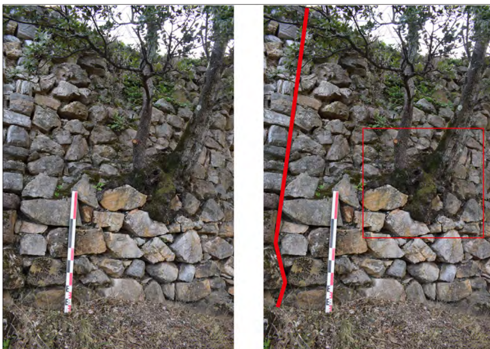
III. 24 : Vue de la souche et du coup de sabre avant arrachement.
