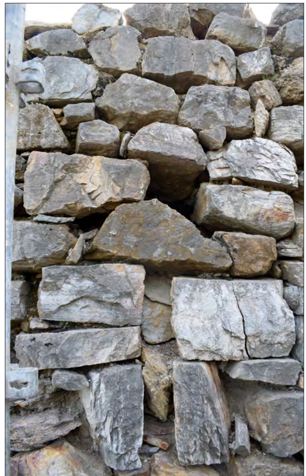
III. 53 : Vue depuis l'ouest de la meurtrière.
