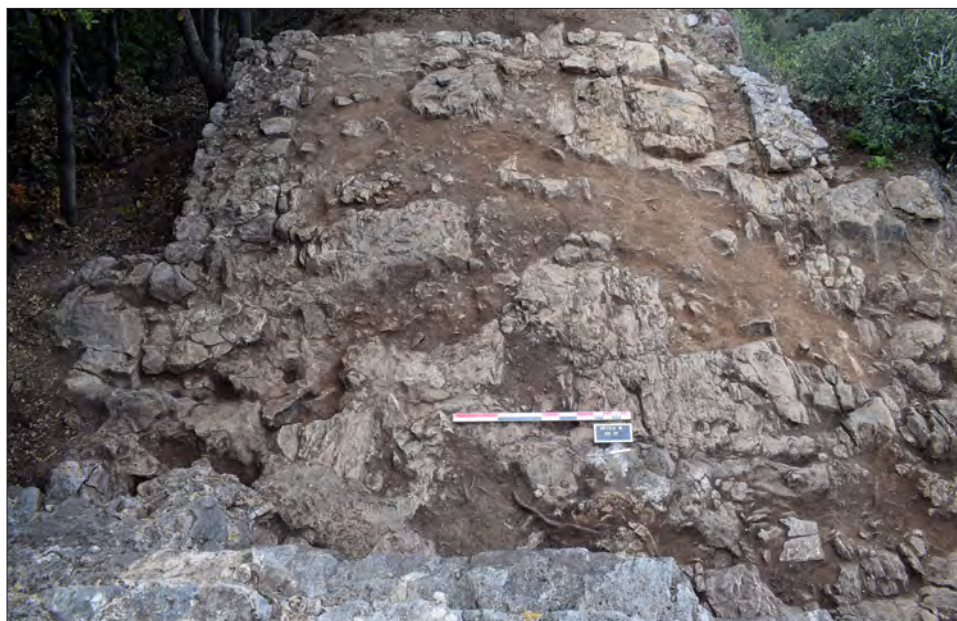
III. 14 : Vue cavalière depuis l'ouest de l'ensemble 1 après décapage.
