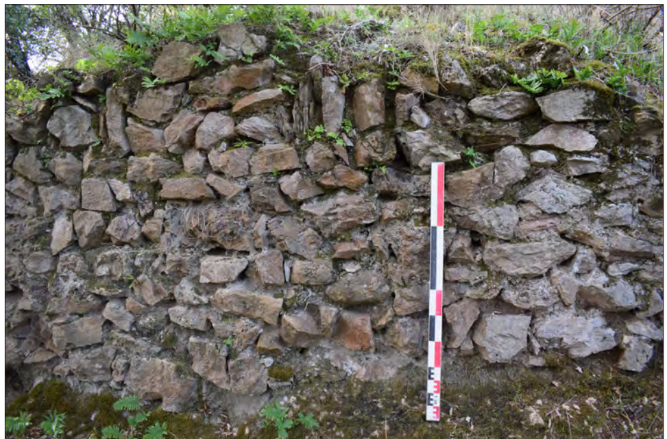
III. 38 : Vue depuis l'est du mur de terrasse.
