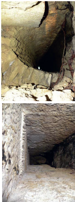
L'aqueduc F.2004 en partie ouest (g.) et en partie est (d.). Le canal ouest a une hauteur de 1,20 m pour une largeur de 0,75 m.
