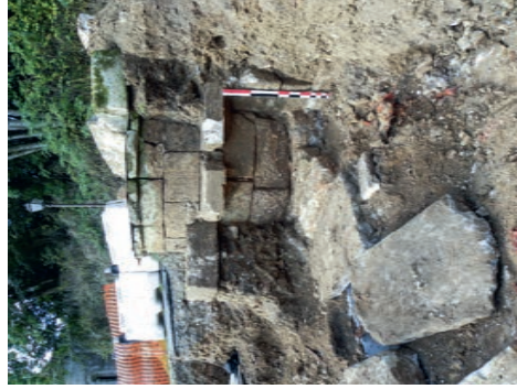
Le cuvelage de la fontaine et la jonction de l'aqueduc nord
