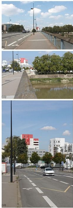
Pont Willy Brandt, Logements Phare des Alizés : effet de phare, domination visuelle, avancée des couleurs, chaleur/froid
