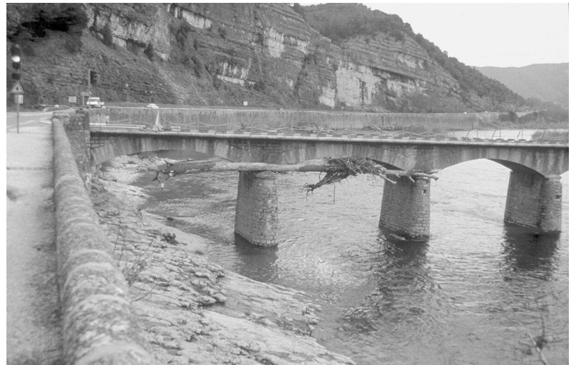
Photo 1 : Laisse de crue (embâcle) déposée sur la pile d'un pont sur l'Ardèche à Sampzon (13 janvier 1998).
