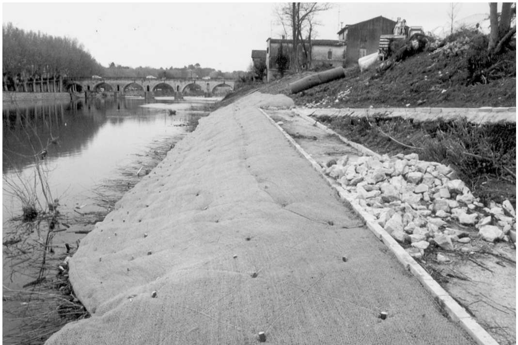
Photo 3 (ci-contre) : Pose du géotextile. Au fond, le Pont de Sommières entièrement recouvert par l'eau lors de la crue du 9 septembre 2002 Photo D.A.
