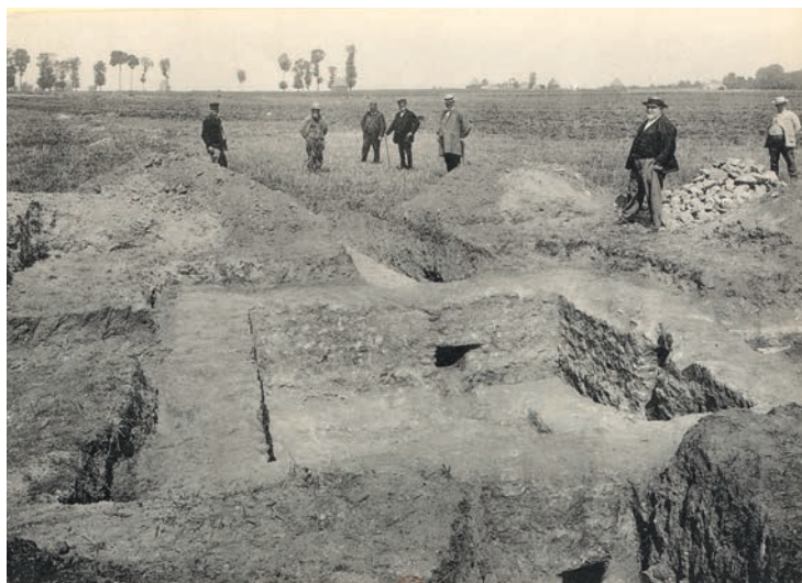
22. Le bassin romain de Wissous (91) de l'aqueduc de Lutèce, vue d'ensemble.
