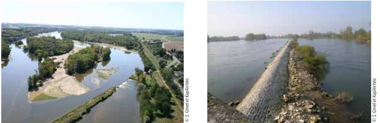
Figure 2.20. Exemples de chevrettes permettant d'orienter l'écoulement et de faciliter la navigation sur la Loire.
