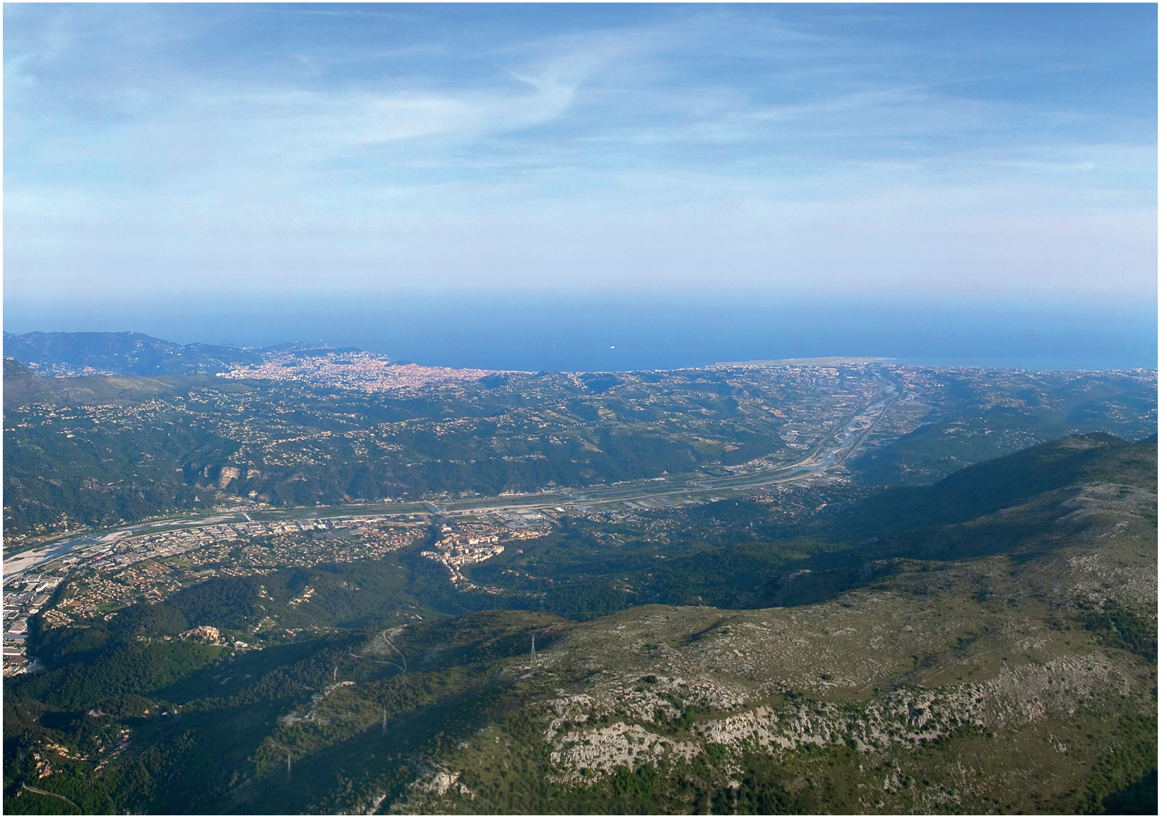
Figure 6. La Plaine du Var depuis le nord (photo P. Behar, MNCA)
