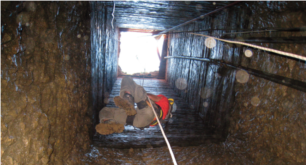
Fig. 43. Sainte-Croix - L'Auberson. Vue de l'intérieur du puits (photo M. Liboutet, AC).
