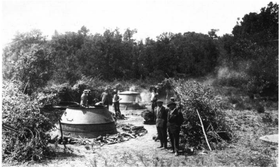
Photo 2 : Fonctionnement de four à bois pour la fabrication du charbon de bois - Forêt domaniale de Cadarache
