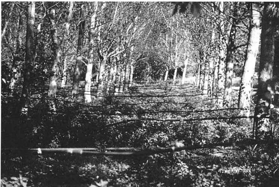
Photo 1 : Système d'épandage des eaux usées par micro-irrigation localisée à Opède (84).
