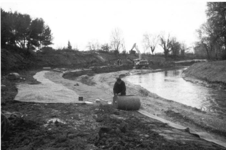
Photo 1 : Travaux de protection des berges sur l'Arc, de plus en plus les entreprises élargissent leurs champs de compétence, les travaux en forêt ne suffisent plus à les faire vivre. Photo L. Viallon/ Forêt Plus
