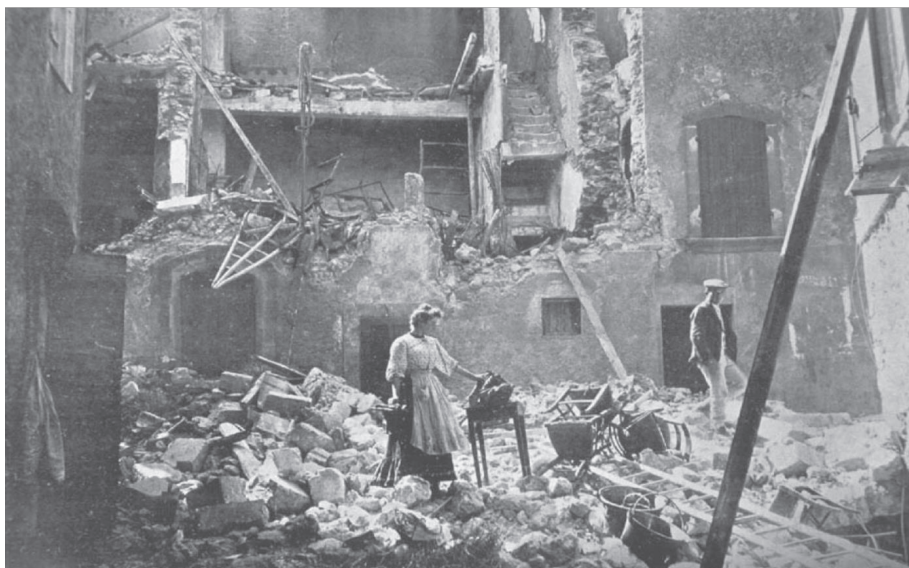
Figure 10. Dommages relatifs au séisme de Provence (ou de «Lambesc»), le 11 juin 1909. (Crédits : Collection Guy Perrier.)
