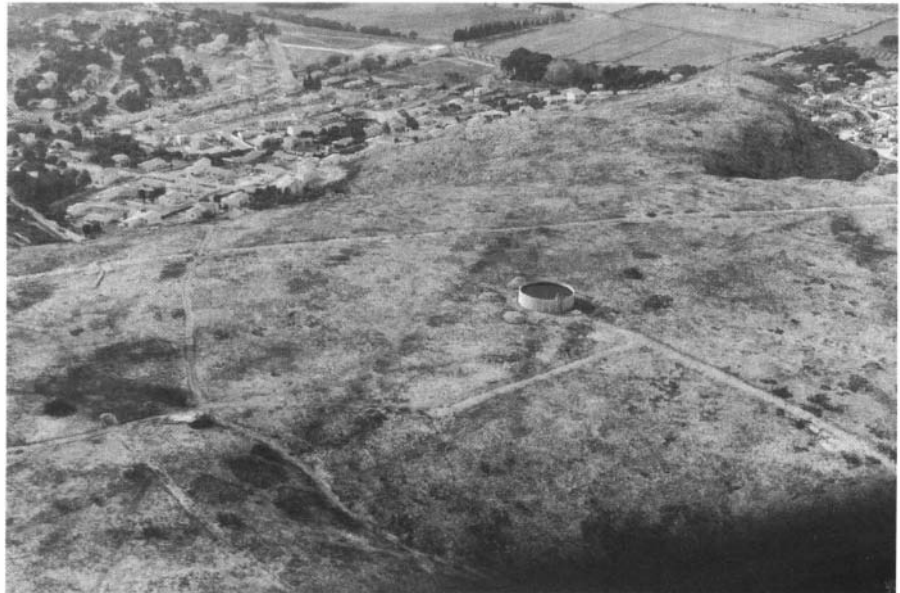
Photo 7 : Vue aérienne : équipements D.F.C.I.
