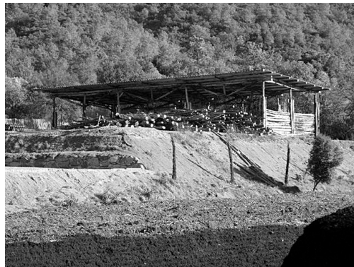
Photos 2 et 3 : Hangar de la Môle (Var) Photos Jacques Brun / Sivom du Pays des Maures
