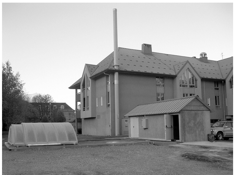
Photo 4 : Vue extérieure de la chaufferie bois et du silo du réseau de chaleur du quartier de Laroche à Embrun (05) Photo Communes forestières 05
