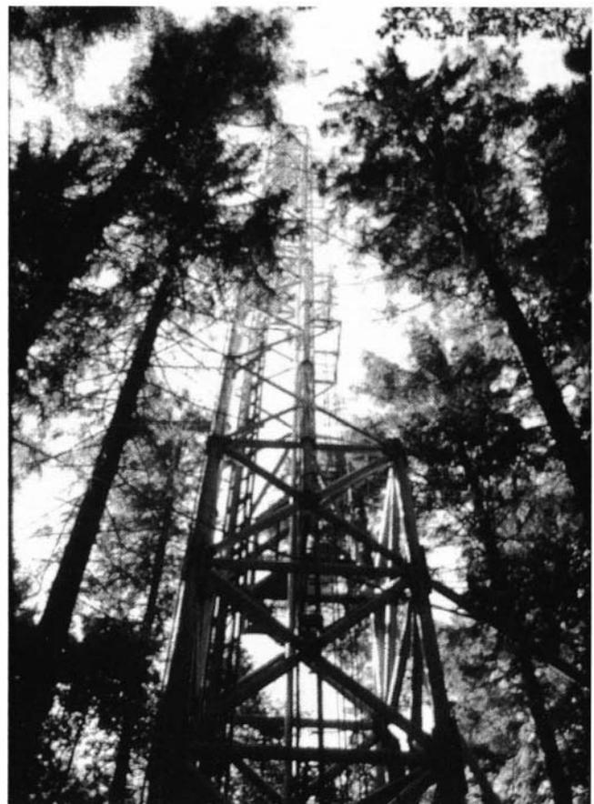
Photo 1 : Tour de mesure de la teneur de l'air en NO<sub>x</sub>, SO<sub>2</sub>, O<sub>3</sub> près du Col du Donon (Vosges).
