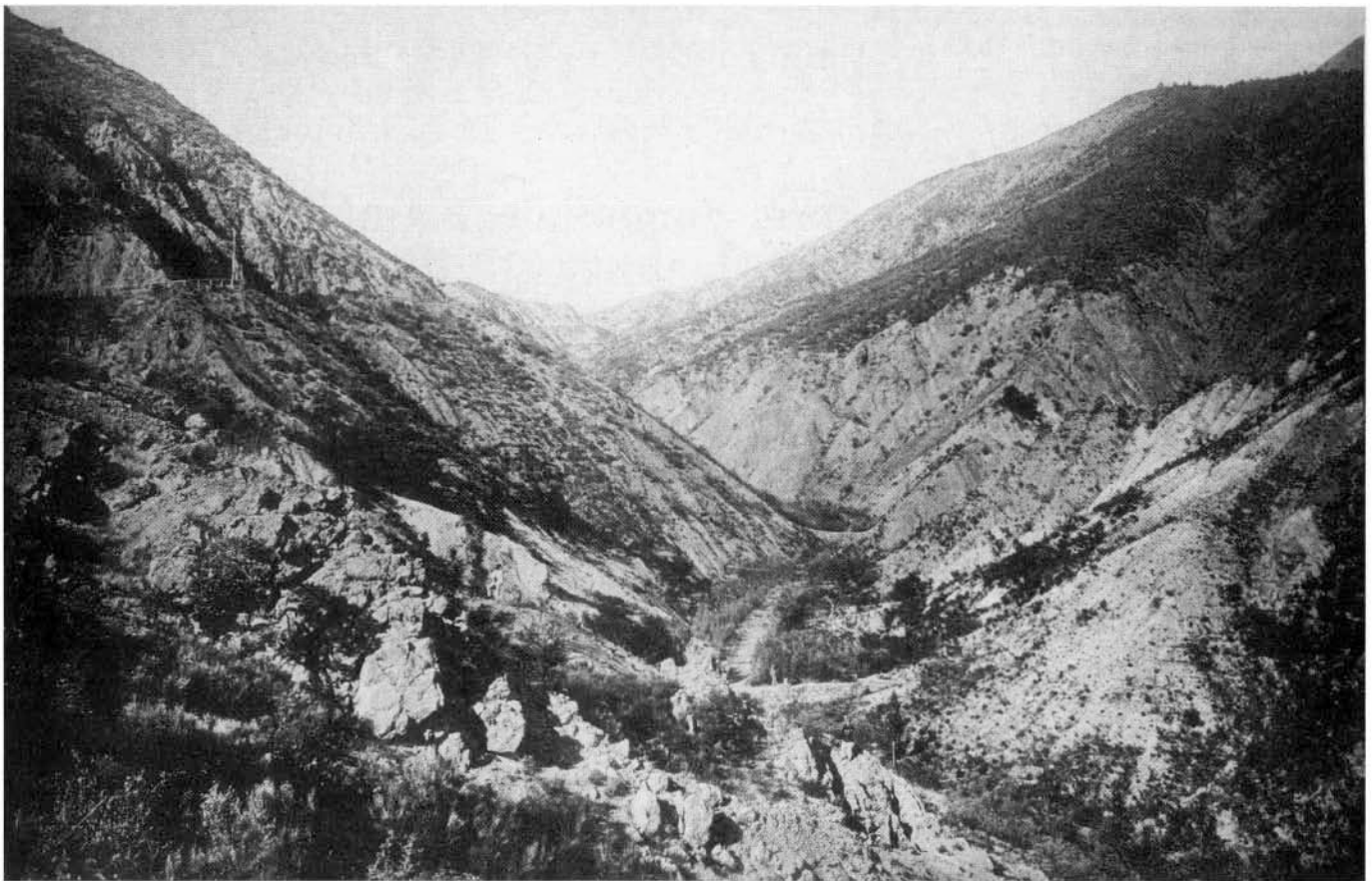
Photo 5. Le torrent du Labouret - Vue de 1877 : noter la nudité des versants où l'on distingue les rangées de plants et les barrages en fond de vallon.
