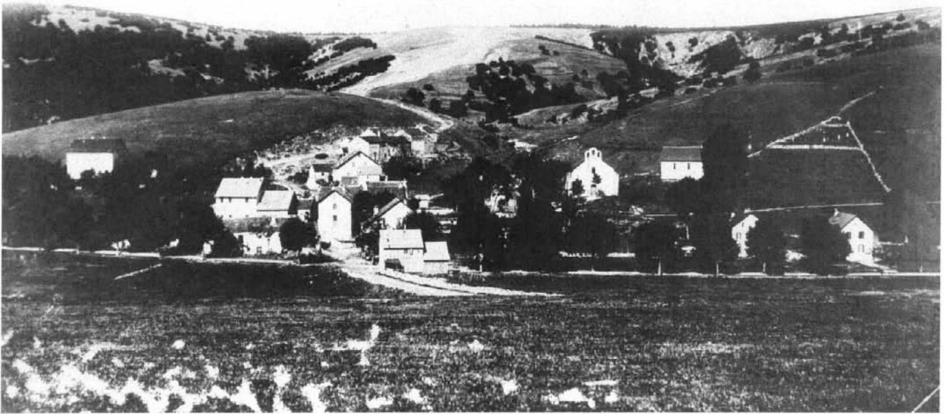
Photos 19 - 20. Commune de Valleraugue - L'Esperou - en haut septembre 1904 - en bas novembre 1982. Photos O.N.F.
