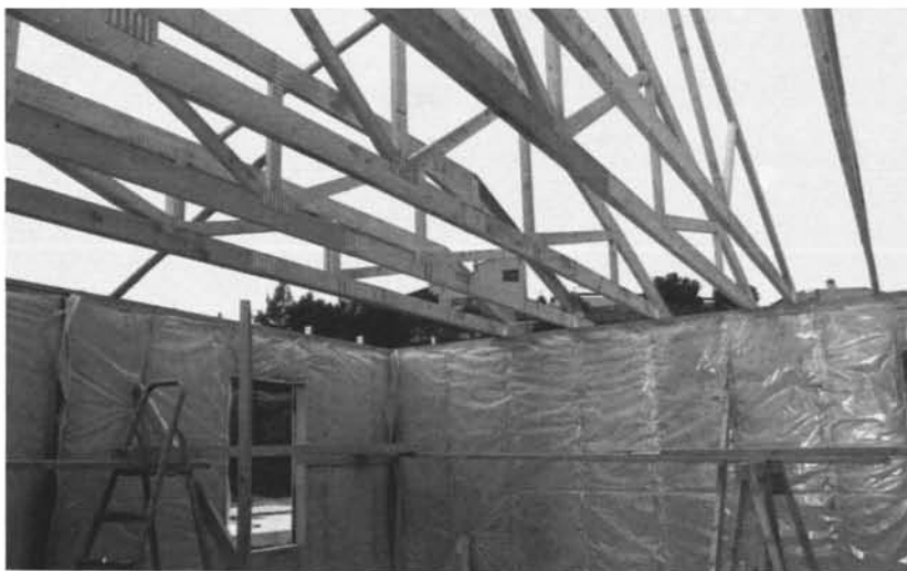
Pose des fermettes et de l'isolation + pare-vapeur intérieur sur l'ossature. Photo E. M.
