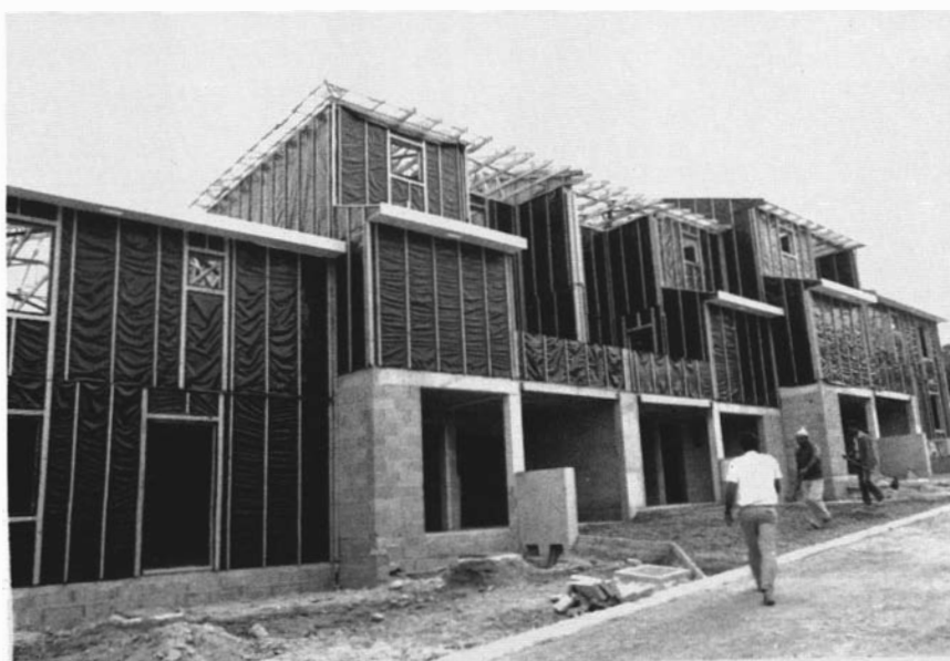
Un lot de gros œuvre terminé à Istres (voir ci-contre). On voit bien les éléments d'isolation thermique insérés dans la structure bois. Photo E. M.
