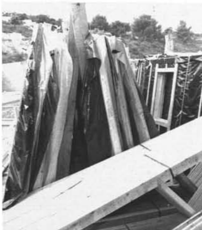
Réception d'une maison « en kit » : panneaux avec pare-vapeur, fermettes. Photo E. M.
