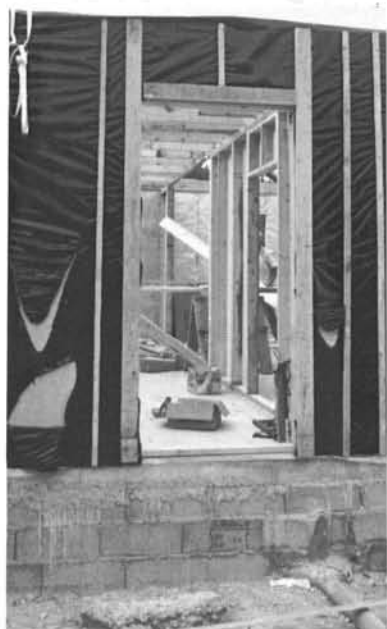
La dalle de maçonnerie supportant l'ossature bois. Photo E. M.
