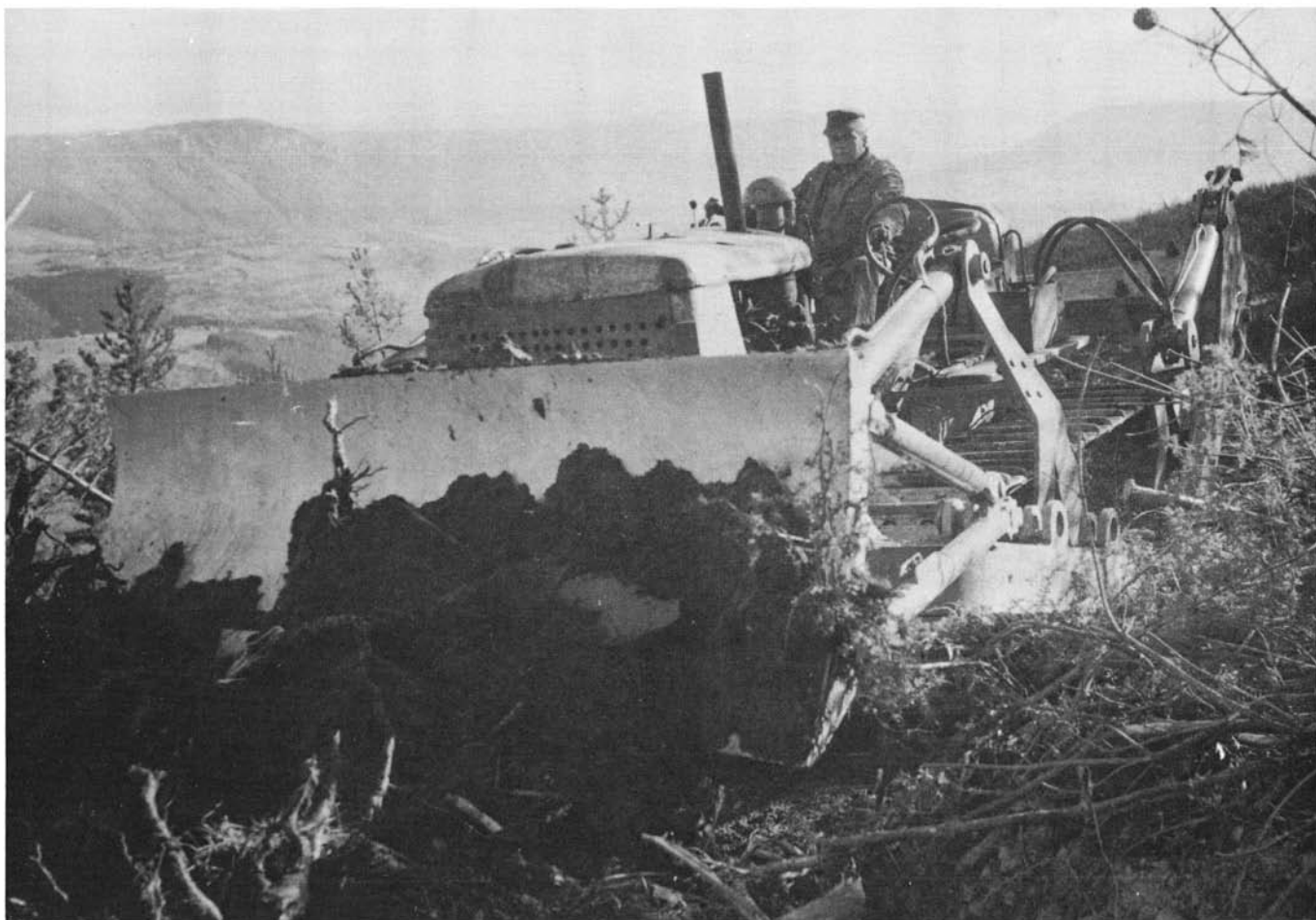
Photo 20. — Travaux sur terrains en pente. 1. Ouverture de banquettes contrat F.F.N. de Bahours — S.C.I. de Gévaudan 1962. Photo R. S.B.
