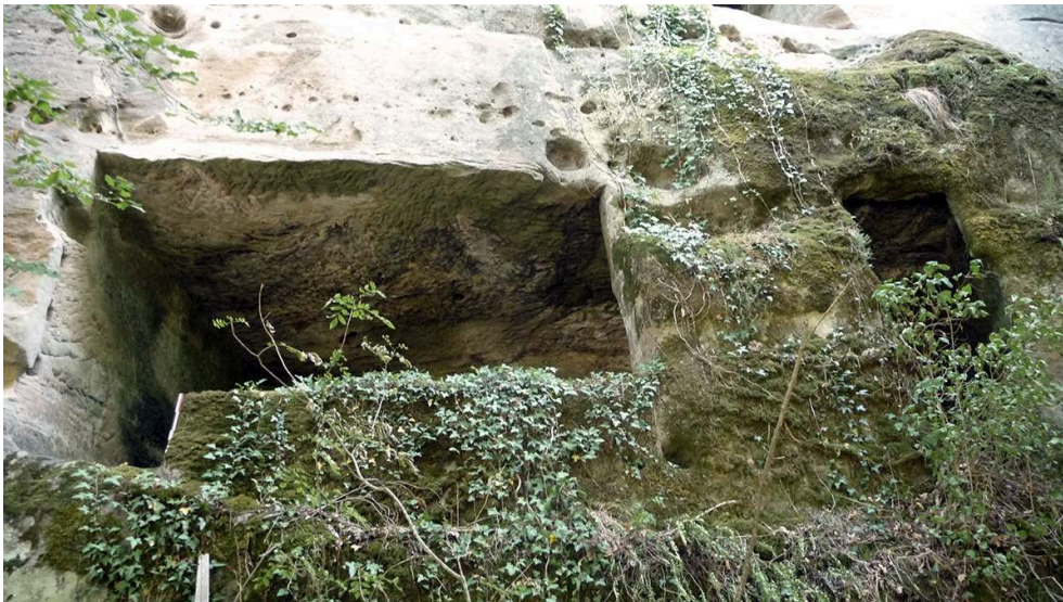
Fig. 4. Vue de l'UP6 (façade extérieure) de la cellule 2 du site de Puyjarrige (Brive-la-Gaillarde). Les ouvertures ménagées dans la roche sont bien visibles : une porte (à gauche), un mur bahut (au centre) et une fenêtre (à droite) (M. Liboutet).
