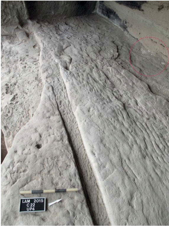
Fig. 10. Site de Lamouroux (Noailles). Vue du sol de la cellule 22. Au premier plan, rainure pour insertion d'une sablière. Vestiges de mortier (entouré en tiretés rouges) (M. Liboutet).
