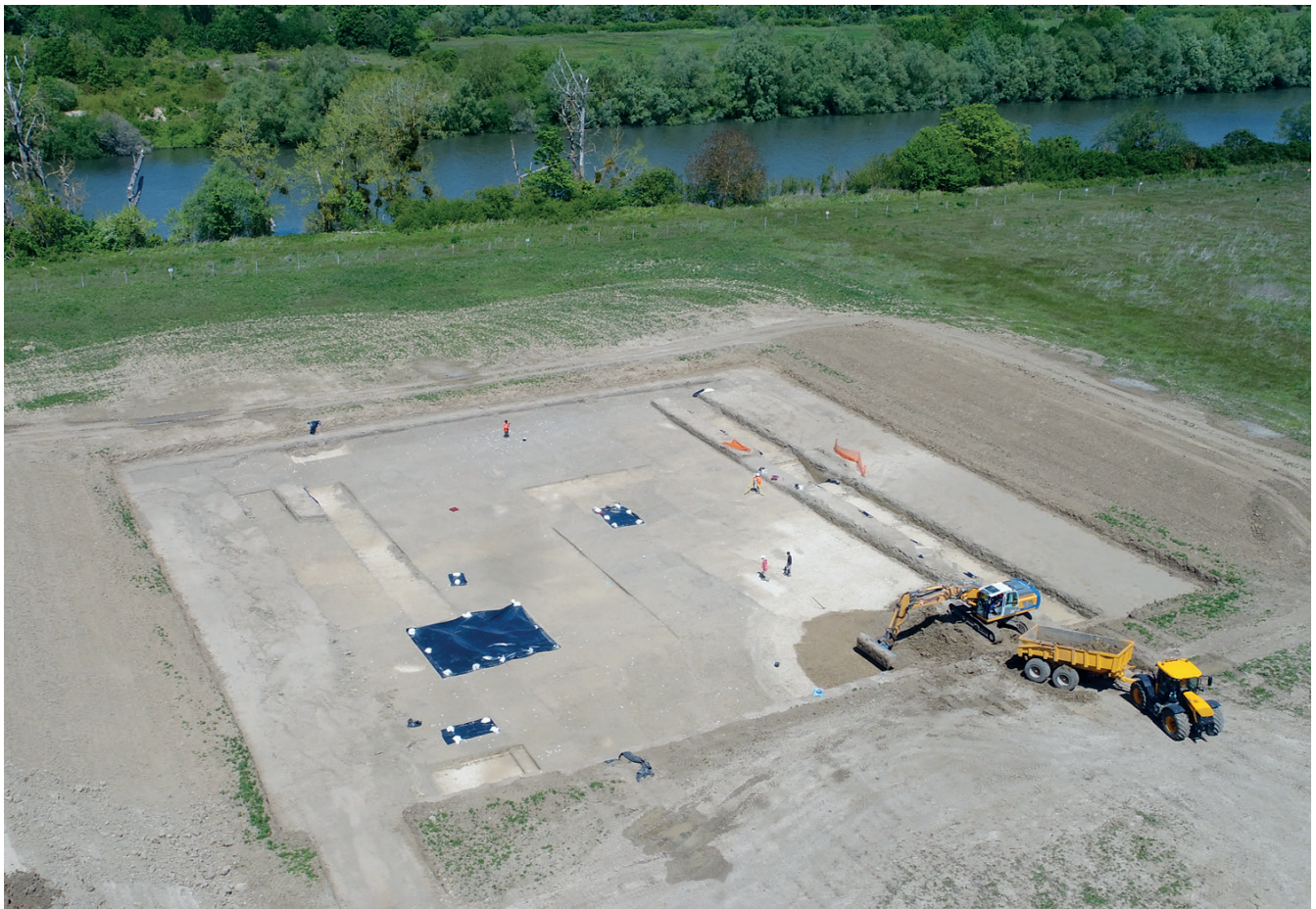
Figure 2 : Vue générale de la fouille en bord de Seine (cliché P. Raymond)
