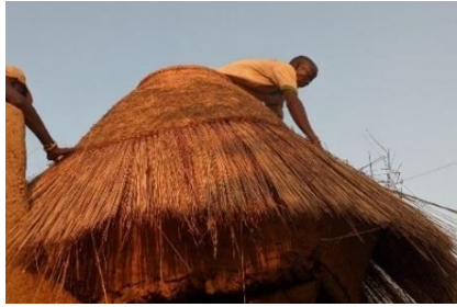
mise en place des rouleaux de paille sur le grenier jusqu'au col
