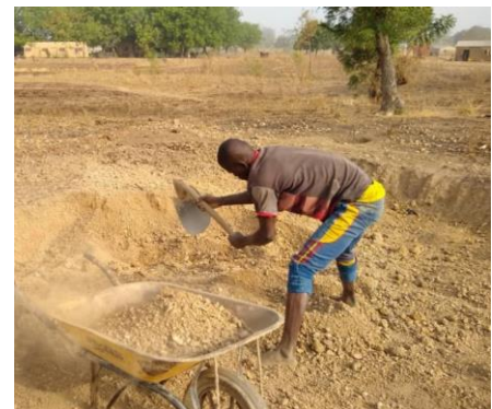
Extraction de terre à Nadoba
