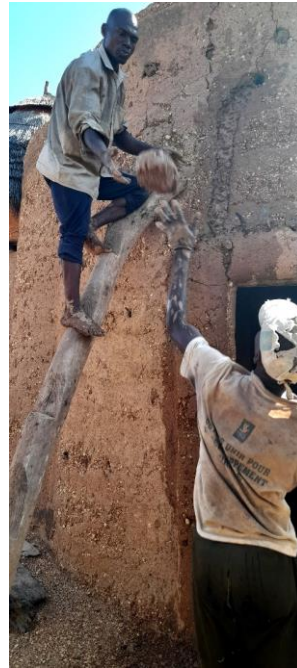
Remplissage de la partie à colmater
