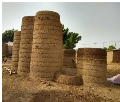
Construction des tourelles, les plus hautes ont nécessité 15 levées de terre
