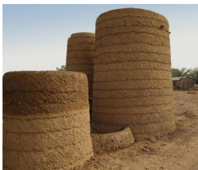
Construction des tourelles, les plus hautes ont nécessité 15 levées de terre
