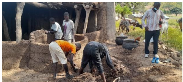
Préparation des boules et façonnage de la quatrième assise
