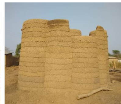
Tourelles et murs terminés
