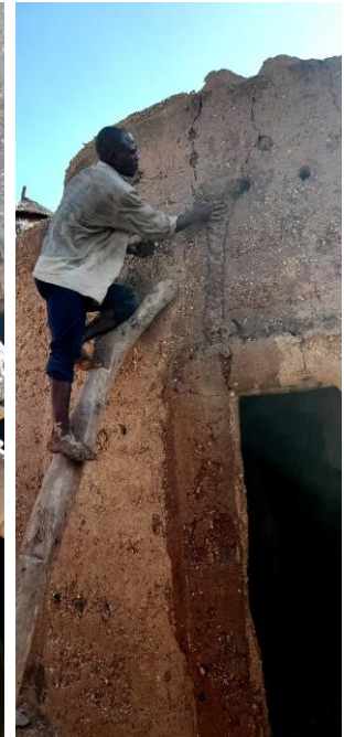
Remplissage de la partie à colmater
