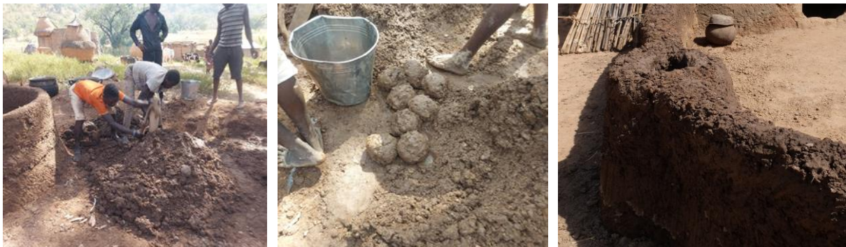
Malaxage de la terre destinée à l'élévation des murs
