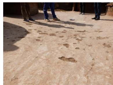
Usure de la toiture-terrasse
