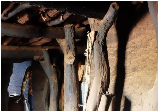
Poutres espacées d'environ 80 cm portant sur des poteaux fourches
