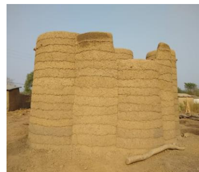
Tourelles et murs terminés
