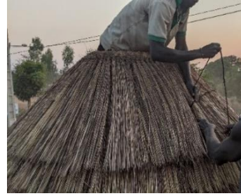
mise en place des rouleaux de paille sur le grenier jusqu'au col
