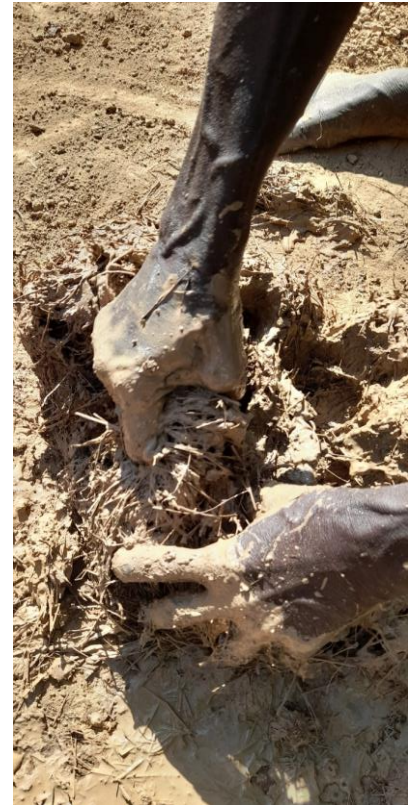
Malaxage des fibres avec la barbotine
