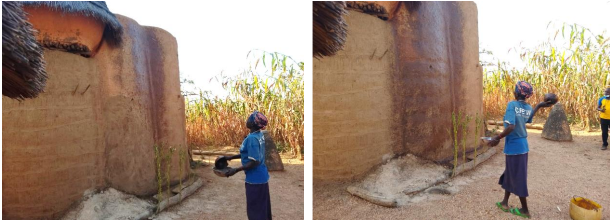
Projection du badigeon sur les parois avec une petitealebasse
