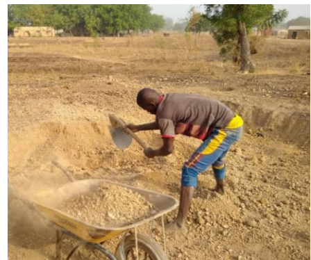
Extraction de terre à Nadoba
