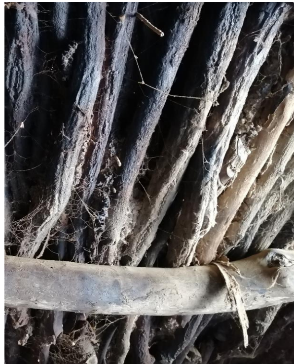
Poutre supportant des poutrelles
