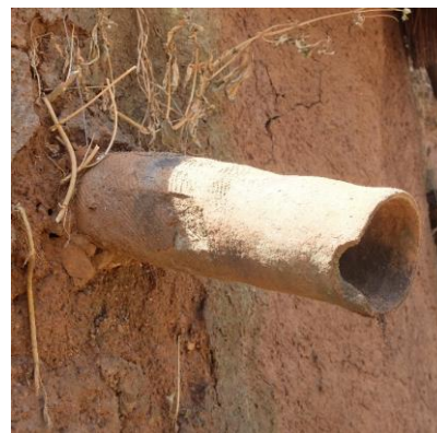
Gargouille endommagée
