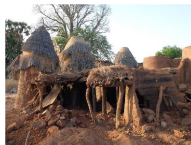
Usure de la toiture-terrasse
