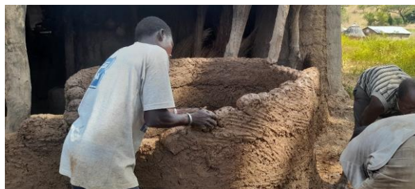
Façonnage de la quatrième assise
