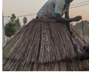
Lorsque les pailles pourrissent ou se détachent, elles sont remplacées ou simplement recouvertes d'une nouvelle couche de paille. Il est observé que la paille pourrit plus rapidement sur la zone en contact avec l'échelle.
