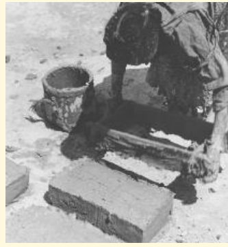
Removal of the wooden frame – technique so-called « à coup d'eau » – Tibet (1938)
