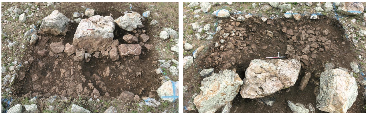
fig. 59, 60 : Construction d'un mur de soutènement : gros blocs, petits blocs à l'arrière et drain de remplissage
