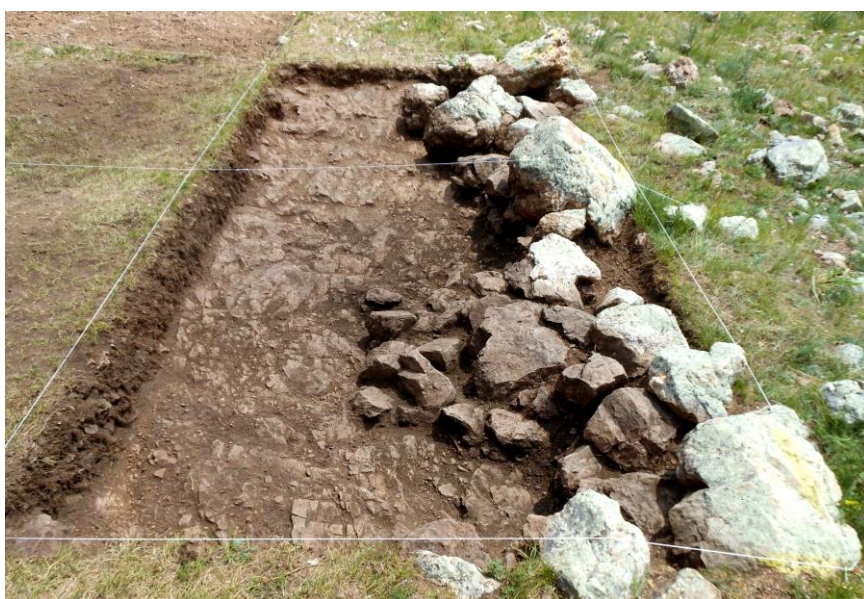
fig. 59, 60 : Construction d'un mur de soutènement : gros blocs, petits blocs à l'arrière et drain de remplissage
