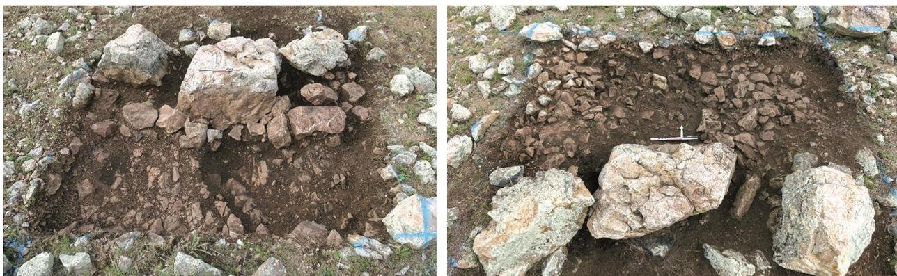
fig. 59, 60 : Construction d'un mur de soutènement : gros blocs, petits blocs à l'arrière et drain de remplissage
