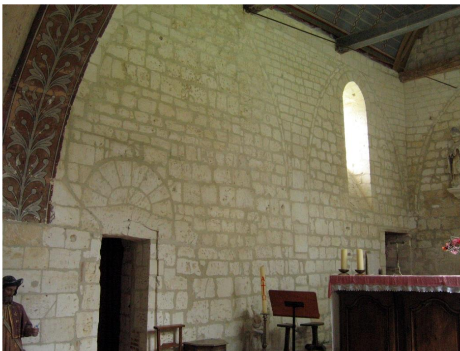
Fig. n° 9. Blangy-sous-Poix, mur nord du chœur. Photographie D. Hanquiez
