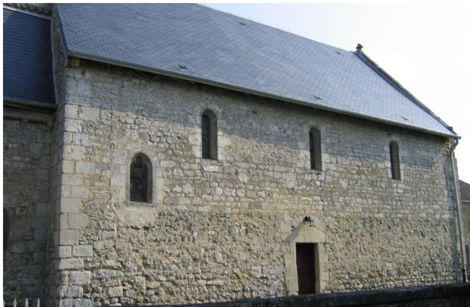
Fig. n° 11. Auvillers, mur nord de la nef, porte surmontée d'un linteau en bâtière. Photographie : D. Hanquiez
