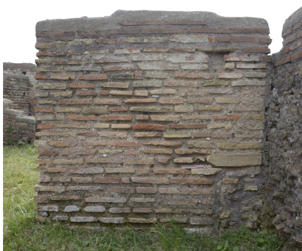
Fig. 6. Edificio IV, X, 2: panca in muratura inglobata nel muro sud dell'ambito B (© Marcello Turci)
