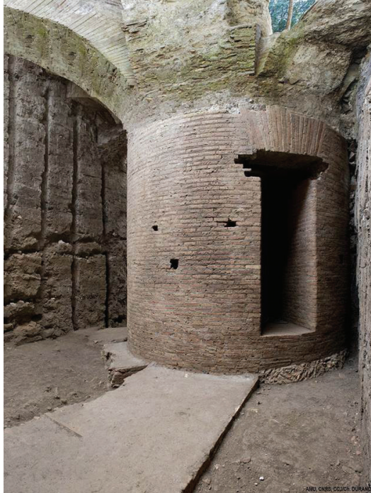
FIG. 7 b. – Porte de sortie de l'escalier hélicoïdal au sommet de la tour supportant la salle à manger tournante de Néron.
