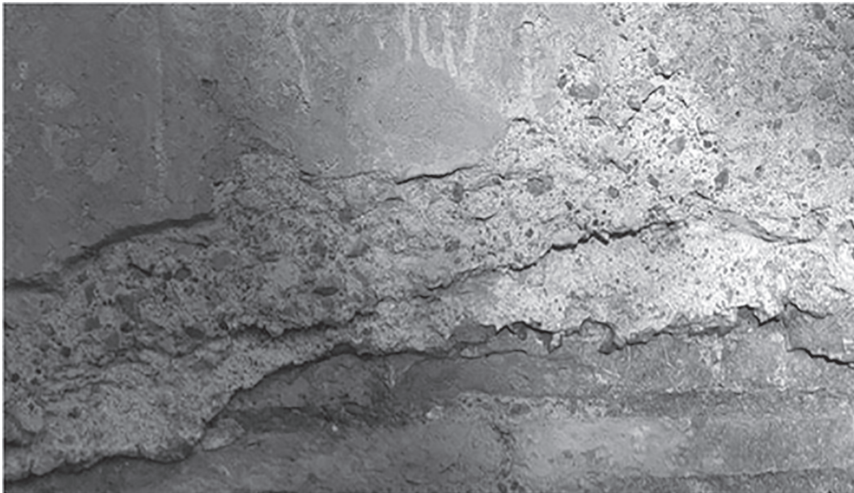
Fig. 9 – Portus , cd Magazzini Traianei, facciata delle celle F 49 et F 50: differente realizzazione della cortina laterizia nella parte inferiore, originariamente rivestita con cocciopesto (tipo 1).
