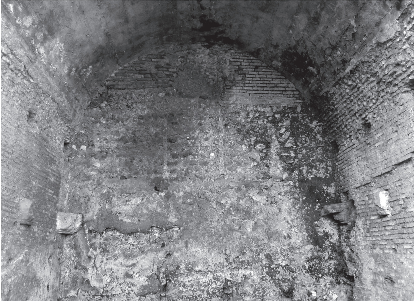
Fig. 12 – Roma, Horrea Vespasiani ; cocchiopesto applicato alla parete in un vano di stoccaggio della fascia perimetrale sud, nel quale la parete di fondo corrisponde a una precedente fondazione in opus caementicium . Il rivestimento in opus testaceum è presente solo nella parte alta, per adattare la fondazione a parete di fondo, tamponando lo spazio tra lo spiccato della fondazione stessa e l'intradosso della volta.
