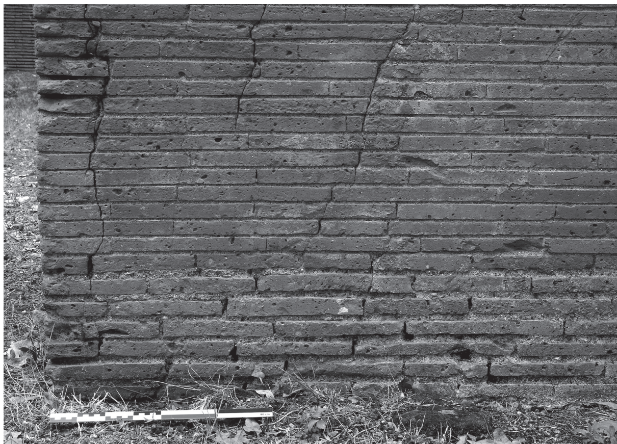
Fig. 9 – Portus , cd Magazzini Traianei, facciata delle celle F 49 et F 50: differente realizzazione della cortina laterizia nella parte inferiore, originariamente rivestita con cocciopesto (tipo 1).
