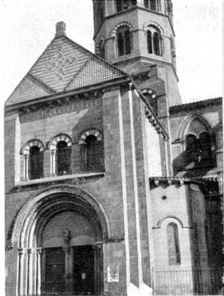
Riom (Puy-de-Dôme). Église Saint-Amable. Pignon polychrome ; restauré.
