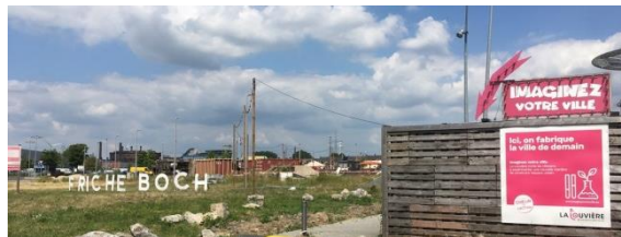
Figure 4: vue sur l'entrée de la friche Boch, La Louvière, 2019. ©L'OCCAUX21 UMONS.
