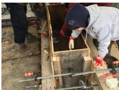
Figure 12 : étudiants en train de réaliser le coffrage du muret mixte terre pisée et rebuts de pierre bleue, La Louvière, 2019. ©L'OCCAUX21 UMONS.
