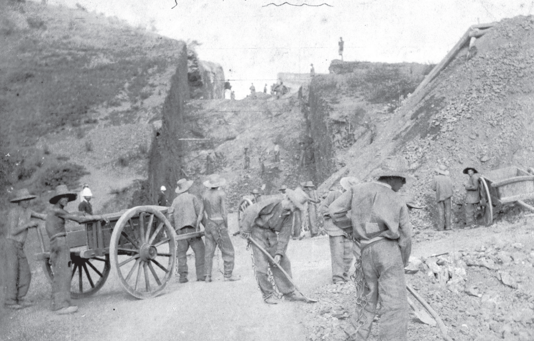
Photo 8. Travaux de routes. Condamnés du camps Brun (Boulouparis) vers 1890. Photographe inconnu, ANC 2 Ph12-3
