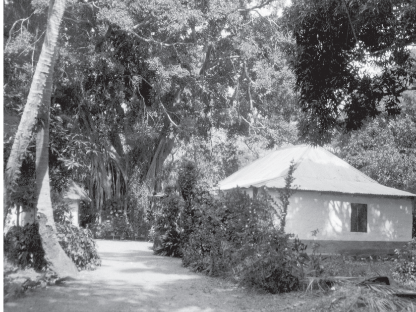
Photo 25. Maison de colon à Voh, autour de 1930.
