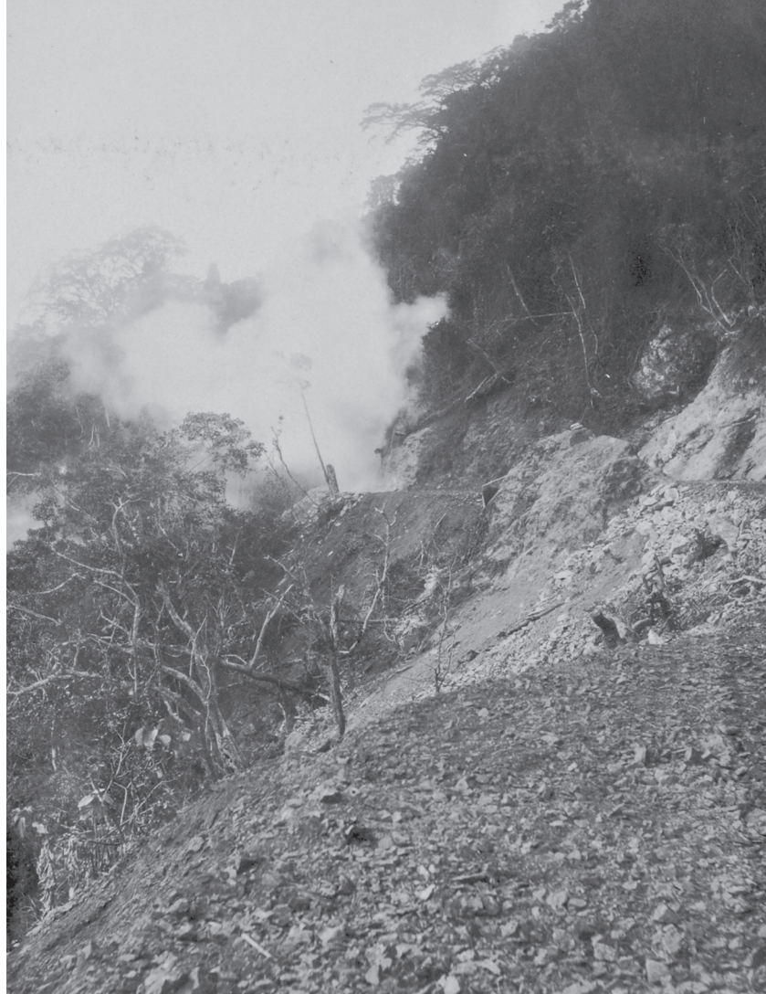
Photo 18. Région de la Table Unio. Travaux de la route du Col d'Amieu à la Négropo, 1902. Cliché attribué à Etienne et Antonin Neuerdein, ANOM, FR ANOM 8Fi76A/44
