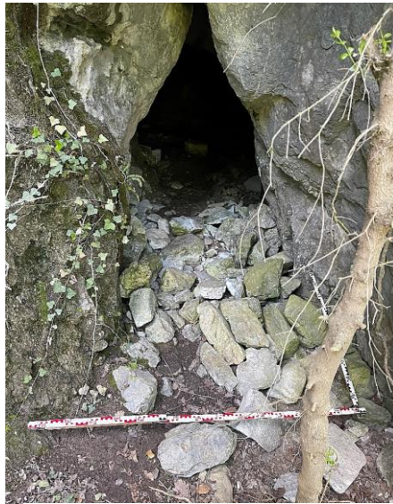
Fig. Le mur éboulé en pierre sèche à l'entrée ouest de la galerie A
