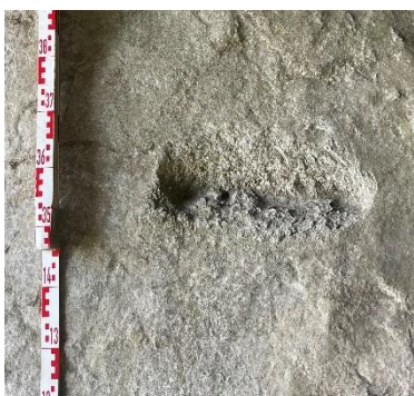
Fig. Encoche du plancher +7,6
