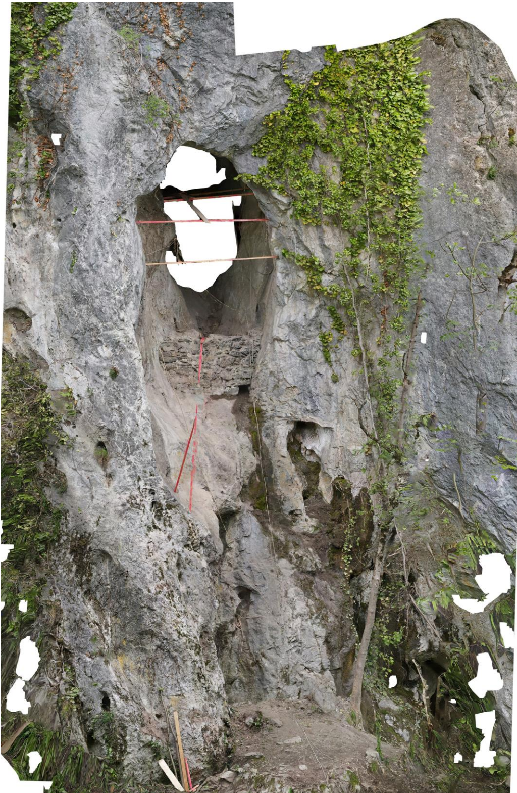
Fig. M1 parement externe et entrée de la grotte fortifiée dans le porche est — orthomosaique de la photogrammétrie
