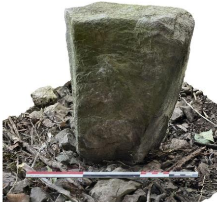
Fig. Orthomosaïque de la photogrammétrie du claveau découvert au pied du porche du M2, à l'entrée ouest de la galerie A
