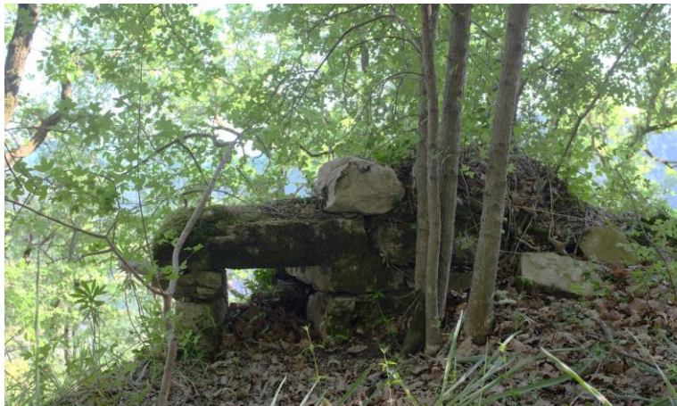
Ouverture à linteau plat dans un mur maçonné situé en aval de la terrasse. Crédit Stéphane Bourdoncle.
