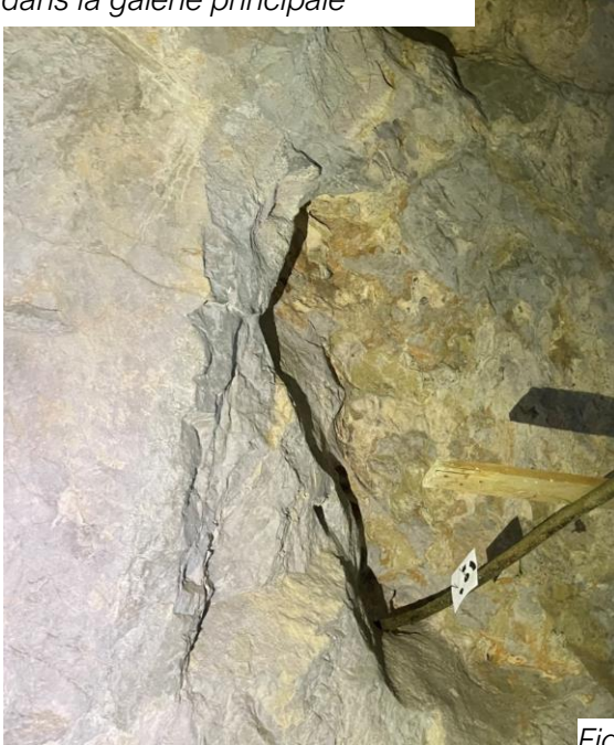
Fig. Exemple de retaille en paroi dans la galerie principale
