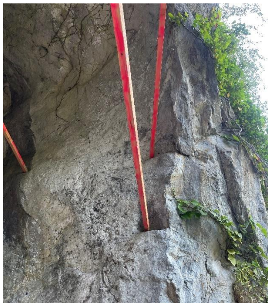
Fig. Deux encoches des niveaux +8,6 et +9,5 au-dessus du mur 1 en paroi ouest.
