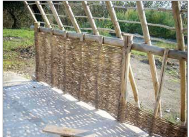
Fig. 18a-c a Nola-Croce del Papa. Moulage naturel de cendres durcies sur les panneaux; b Parc de S. Paolo Belsito. Reconstruction de la Maison 4 de Nola: panneaux de branchages; c Dessin explicatif des panneaux.
