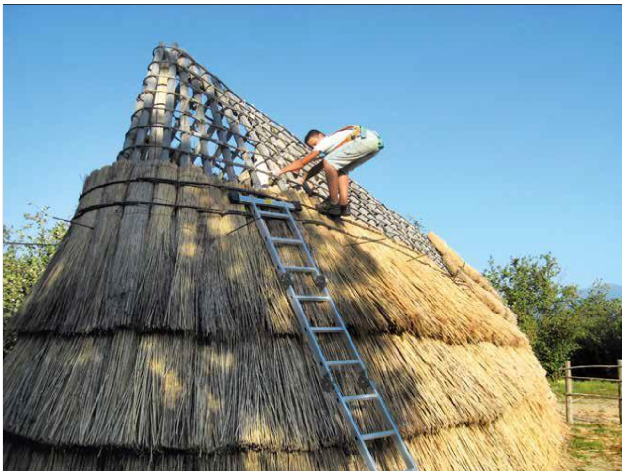
Fig. 24 Parc de S. Paolo Belsito. Reconstruction de la Maison 4 de Nola: mise en place de la fixation externe.
