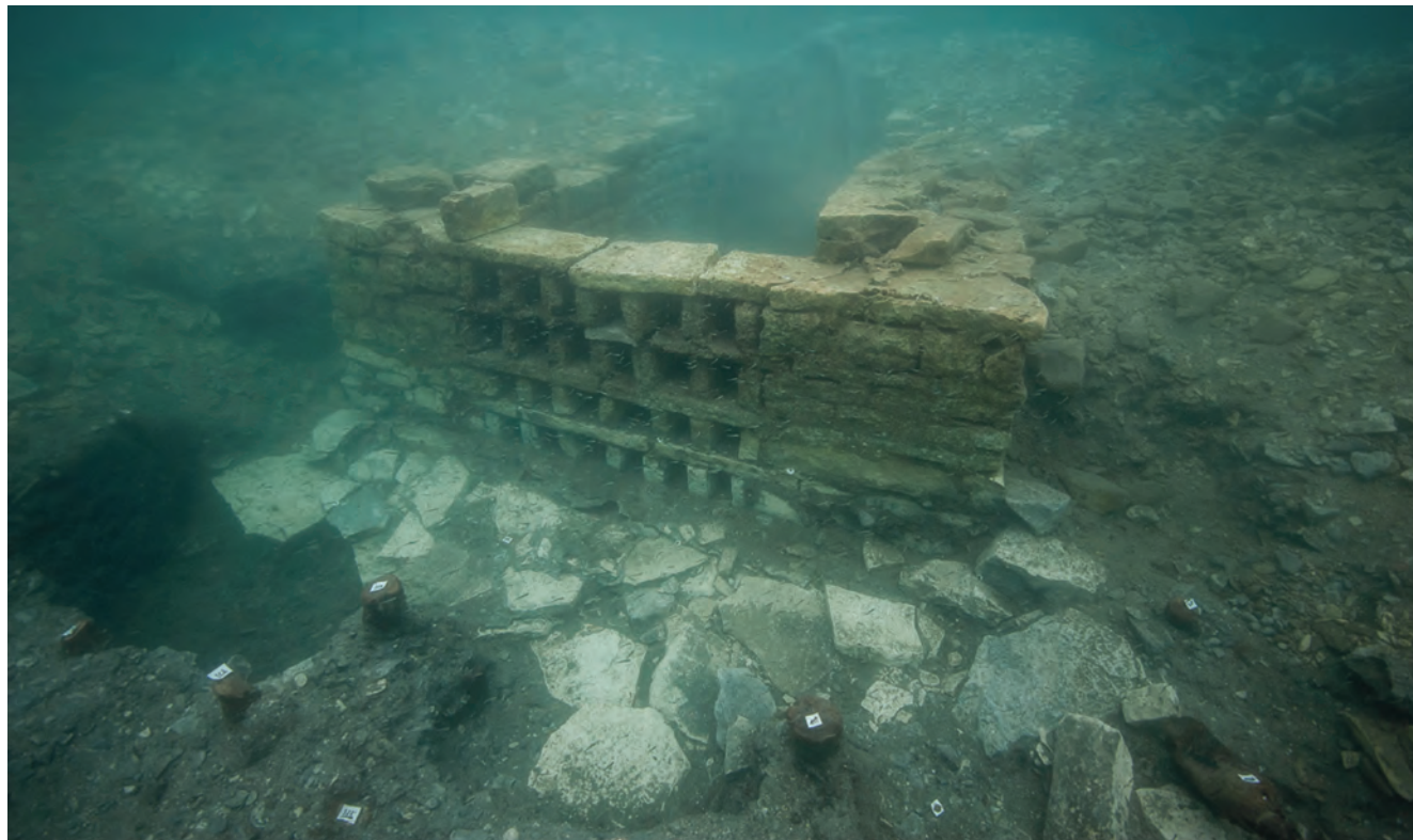
Otvori za vodu vanjskog zida malog istočnog bazena i stupci pristupne platforme izvan ribogojilišta u Busuji / Prises d'eau dans le mur de fermeture du petit bassin oriental et pieux de la plateforme à l'extérieur du vivier de Busuja Foto / cl. Damelet, CNRS/CCJ
