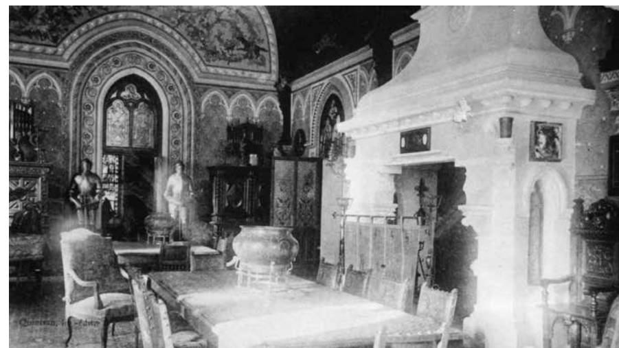
Commanderie des Taillades. Intérieur de la salle d'armes.
