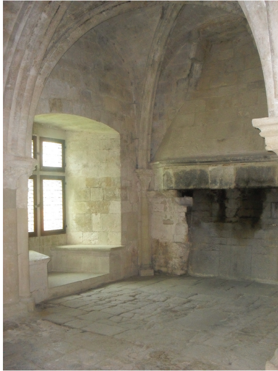
Salle des moines ou chauffoir avec cheminée visible en l'abbaye de Silvacane.
