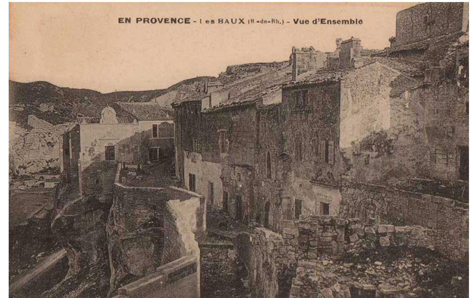
Vue d'ensemble des Baux. Quartier de la porte d'Eyguières.
