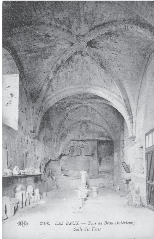
Intérieur de la Tour de Brau.
