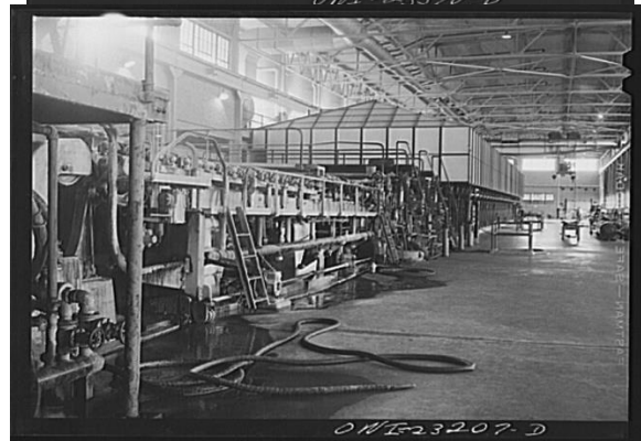
Phase amont du process de papeterie.
